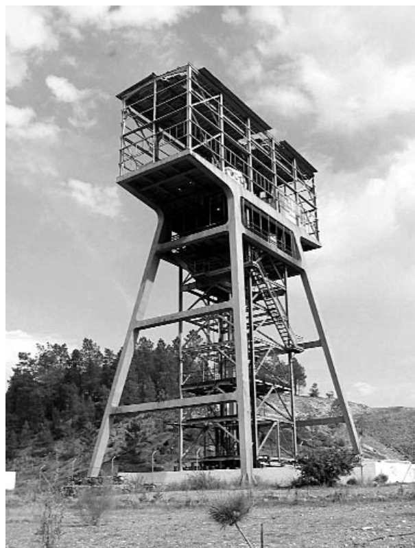
Figura 1: Malacate del Pozo Rotilio
