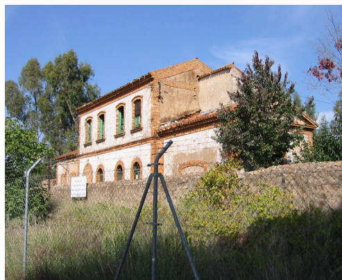
Estación de El Valle
