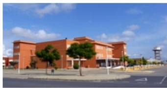
El edificio de la BUH se encuentra en el campus del Carmen.
