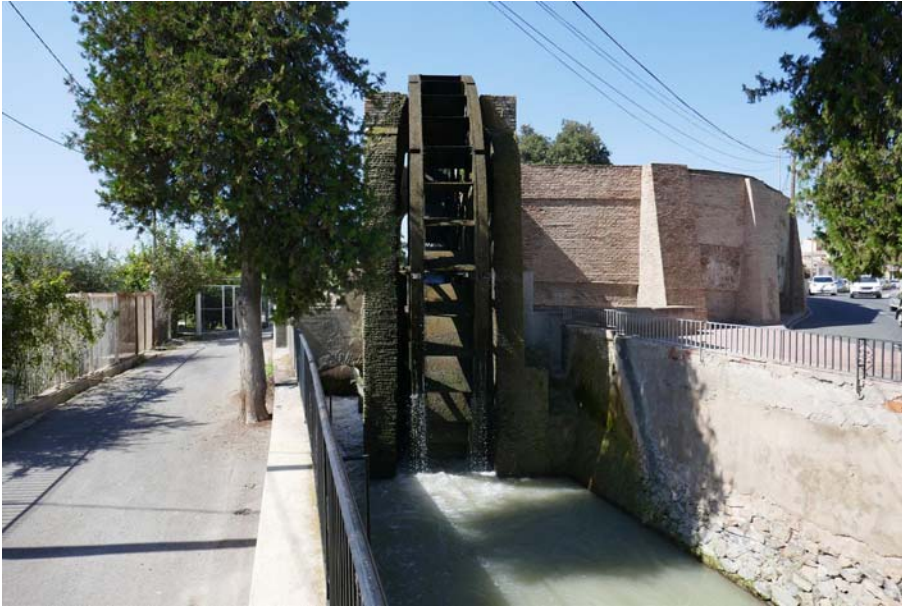
Fig. 4. La Rueda de la Ñora, emplazada en la Acequia de Aljufía, y su acueducto del siglo XV forman uno de los monumentos más representativos de la Huerta de Murcia (Fotografía G. Canales).
