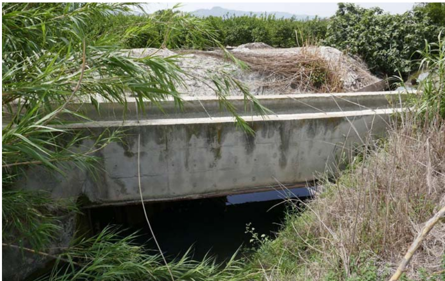
Fig. 5. Caja de la Acequia Nueva del Raal sobre el Merancho del Gil, obra que posibilitó ampliar el regadío en el siglo XVIII (Fotografía G. Canales).
