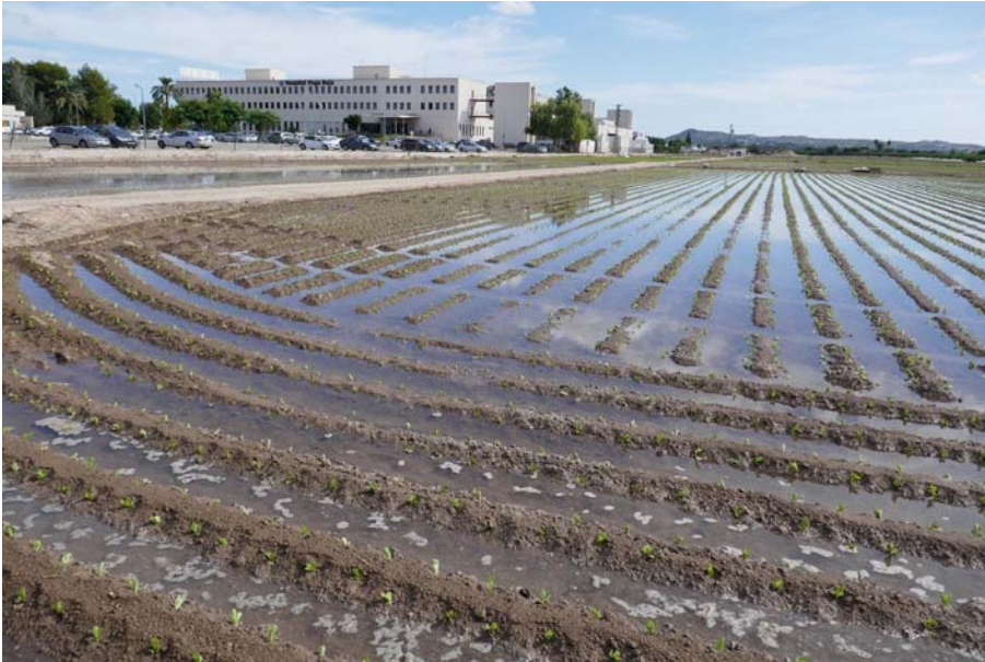
Fig. 10. La carencia de una ordenación del territorio emplazó el Hospital Comarcal de la Vega Baja en pleno llano de inundación del Segura (Fotografía G. Canales).
