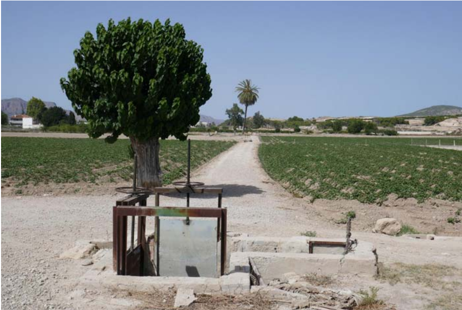
Fig. 11. Entre las diversas alteraciones que ha experimentado la Huerta se encuentra la pérdida de visibilidad de la red de riego, cuyos hitos visibles son los partidores que emergen en los nuevos viarios (Fotografía G. Canales).
