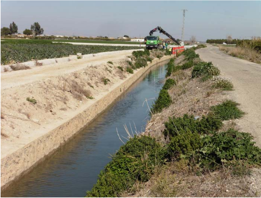
Fig. 8. Las aguas muertas del Azarbe del Término confluyen mediante el Azarbe Viejo en el Azarbe de la Reina, utilizadas en este acueducto como vivas (Fotografía G. Canales).
