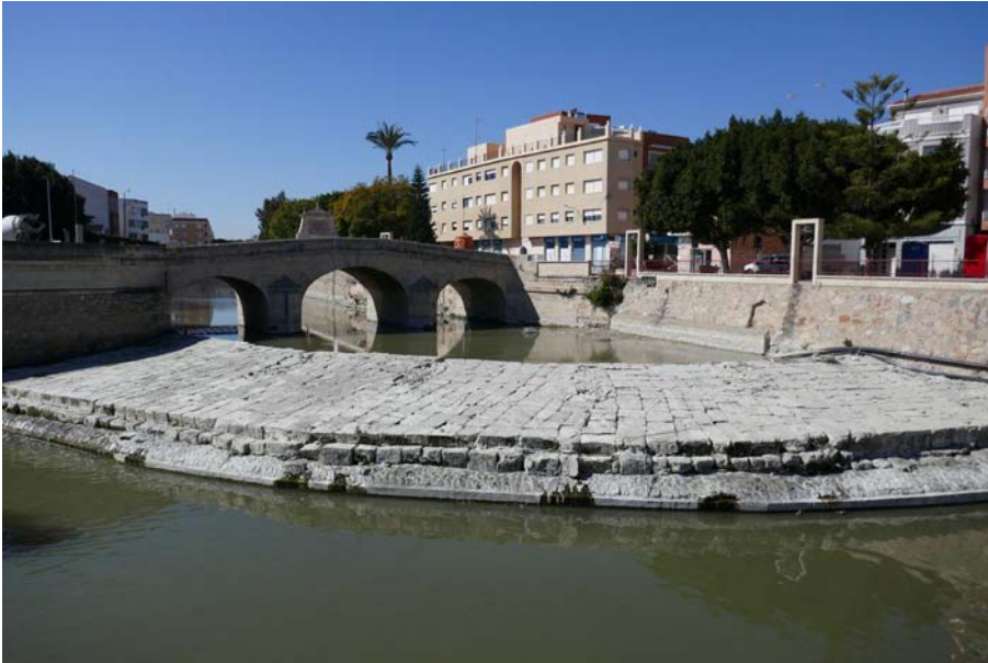
Fig. 3. Azud de Rojas (siglo XVII), modelo representativo de las presas de derivación que dan origen a la red de riego (Fotografía G. Canales).
