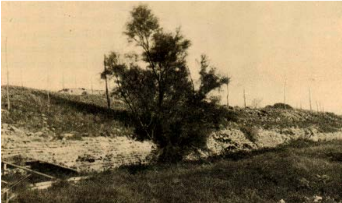
Figura 5. Vista del muelle este-oeste (Lugli, Filibeck, 1930, fig. 47).
