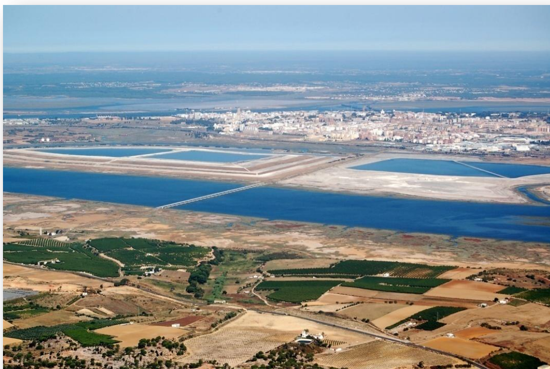
Figura 19. Fotografía aérea de la zona de las balsas de Fosfoyesos (Fotografía de Rodolfo Barón)
